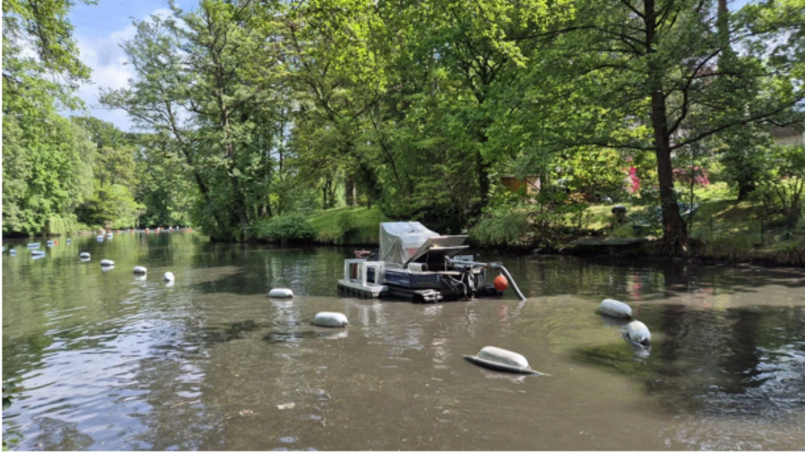
Bojen zeigen auf dem Waldsee an, wo gerade gearbeitet wird und der Schlauch zum Klärwerk verläuft. © Katrin Lange | Katrin Lange
